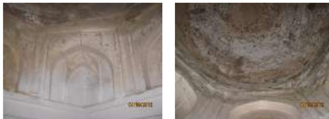
در قسمت هشت ضلعی شامل چهار فیلگوش عمیق دارای گچبری و کاربندی با نقش یک نیم ستاره هشت و چهار پنجره می باشد . هر یک در داخل یک طاقنمای تزیینی قرار دارند و نور داخل مقبره را تامین می کردند این پنجره ها در حال حاضر مسدود شده اند .
