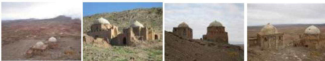
بنای میرمطهر دارای چهار ورودی بوده است لکن در ادوار بعدی مسدود شده اند . پی بنا از سنگ و ساروج<sup>13</sup> تشکیل شده است که بر روی صخره های مسطح دامنه تپه حمل می شود .
