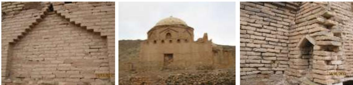
از نظر طرح نقشه و وضعیت خارجی این بنا قابل مقایسه با بابا حاج توکل است ، تنها ایوان و ارتفاع بنا از ارتفاع کمتری برخوردار است. لذا ارتفاع آن به عرض دهانه کمتر است. تفاوت عمده این دو بنا نحوه ای اجرای گنبد بر روی ساقه و استفاده از ملات ساختمانی آجر و ملات گچ است. آجرهای این بنا به ابعاد 20\*30 می باشد.
