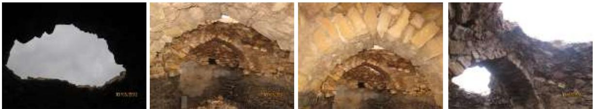
دو متر است که طاق آن با مصالح سنگ و ملاط گچ و آهک به شکل جناقی می‌باشد.
