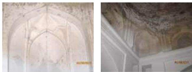
گنبد بنا یک پوششی و از داخل با روش جناغی اجرا شده است. سطح زیر گنبد را اندودی از گچ پوشانیده لکن سبب نفوذ رطوبت و صدمه زیادی دیده است و بایستی مجددا تراشیده و
