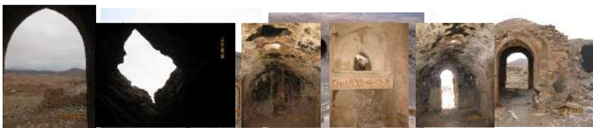
ضلع جنوب شرقی است. ساختمان حمام نسبت به سطح عمودی ارتفاع ندارد، بلکه هم سطح زمین است. تهویه آب به وسیله چند هورنو<sup>21</sup> در سقف صورت می‌گیرد. آب حمام از چشمه قنات در ضلع غربی آن تأمین می‌شود. حمام دارای سربینه و صحن گرمخانه و اتاق نظافت است. خزینه آن در انتهای ضلع شرقی حمام قرار گرفته و گلخن حمام در ضلع شرقی است.
